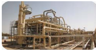
Control microbiológico de los pozos y de los alesajes de petróleo
